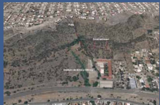
Zona de inestabilidad de talud en el lado septentrional de La Cañada, afectando parcialmente a las instalaciones del Instituto de Artes y Oficios de Querétaro.
